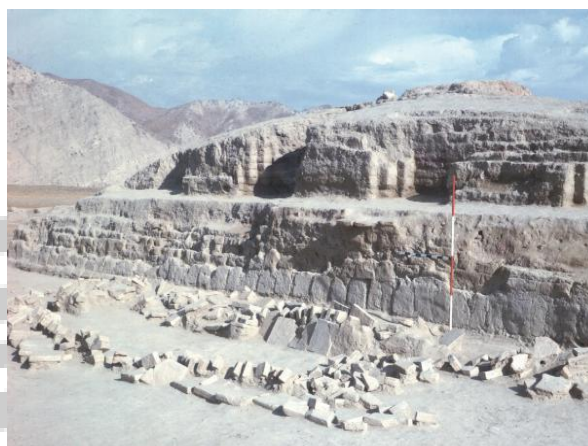
تصویر ۱۸: تعمیرات سکو پرستشگاه از زاویه جنوبی
