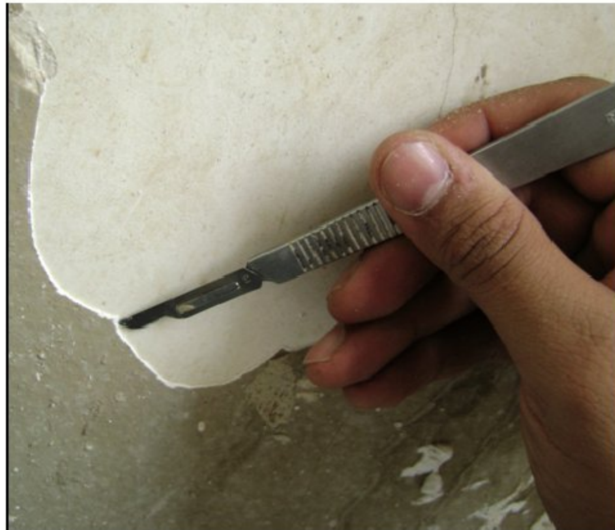
تصویر ۱۳- برداشت مکانیکی لایه گچ رویی ازاره توسط ابزار مکانیکی و به صورت خشک.
