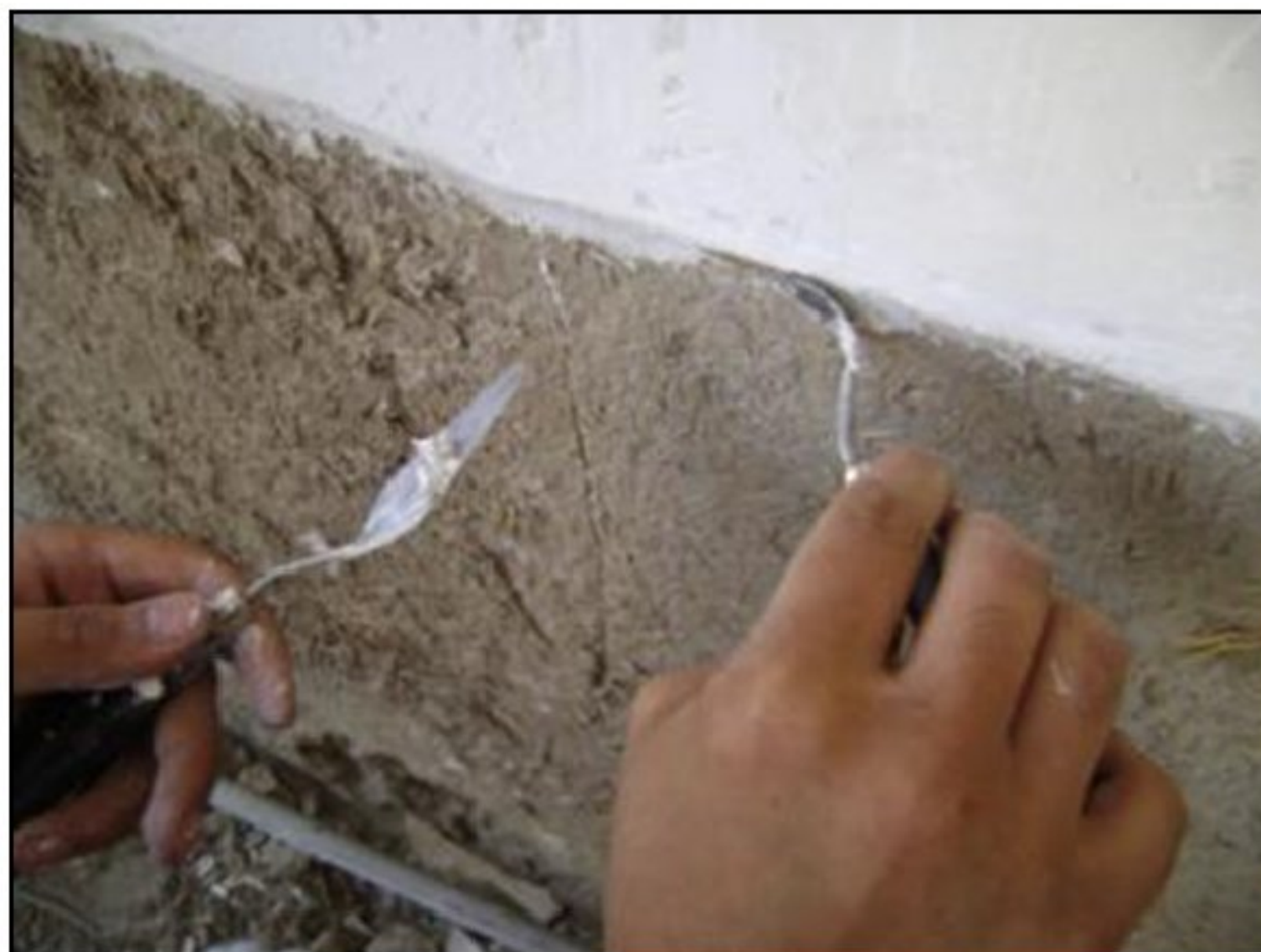
تصویر ۲۰- ایجاد لبه ماهیچه‌ای در پایین کار برای انتقال بار تزئینات و اتصال بهتر آن به تکیه‌گاه و بدنه بنا.
