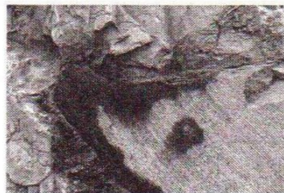
تصویر ۳. شوره‌های ناشی از وجود نمک‌های محلول در مرز
